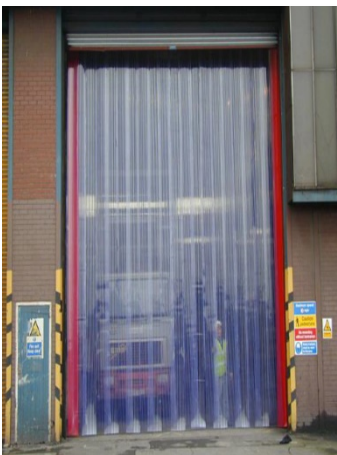
Fig 5.3.18. PVC strip curtains
