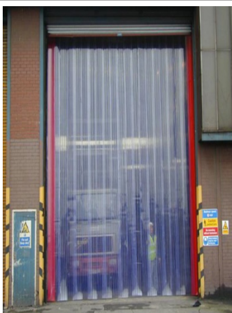
Fig 5.3.18. PVC strip curtains
