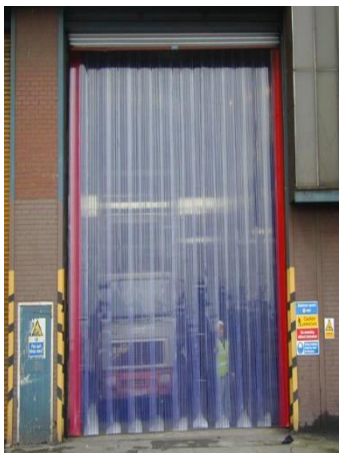
Fig.6.3.18.PVC strip curtains
